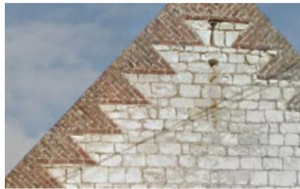
> **La brique** est omniprésente. Elle est édifiée au dessus de soubassements en grès ou en pierre. Elle compose les murs ou bien se limite aux chaînages, linteaux et corniches. Elle peut afficher jusqu'à 5 rangées de briques dont une ou deux canelées sous chéneau. Assemblée perpendiculairement aux rives des pignons, la brique dessine les fameux « couteaux picards ».
