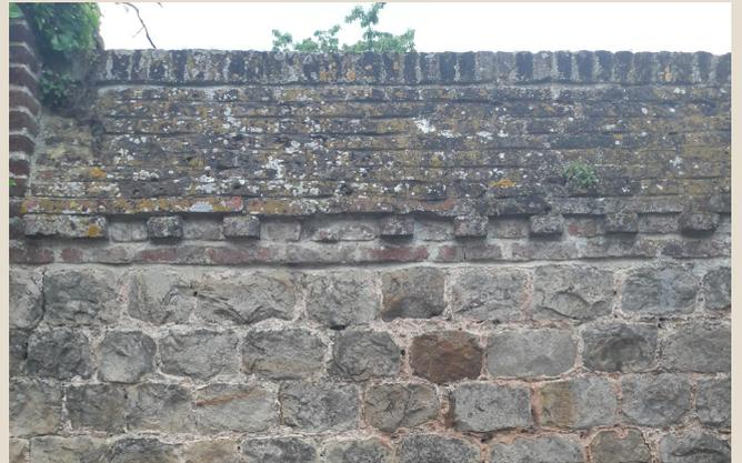
> Conserver au maximum l'état existant des murs et leur aspect original. Le rejointoiement doit se faire à la chaux et posé en légers retrait (<1cm) de la brique ou de la pierre.
