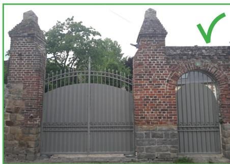
> En cas de percement des murs pour créer un nouvel accès : restituer des piliers dans le même matériaux suivant les proportions (1/4 plus haut) et modénatures de l'existant.
