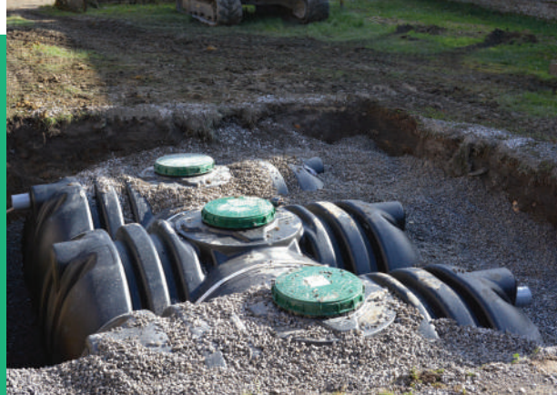
Réalisation d'un assainissement non collectif
