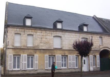
Relais de poste Dehon (1 er Empire) bâti en pierre de taille
