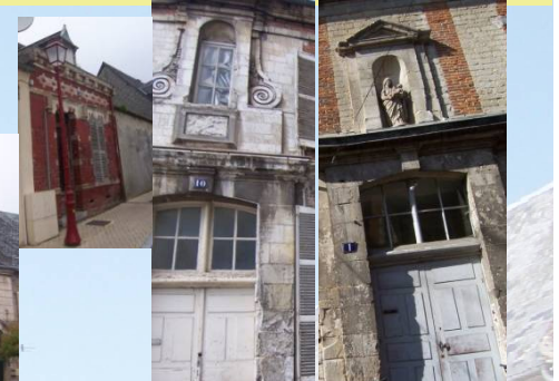
Portes ornées de deux pilastres – sculpture en pierre, ailerons et frontons en pierre Le décor de la fenêtre à gauche date de 1717
