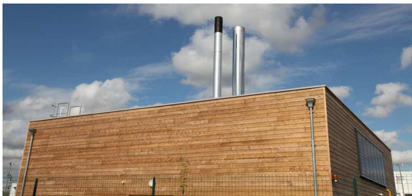
La chaufferie est constituée d'une chaufferie mixte bois (800 kW) et gaz en appoint (1.4 MW) et d'un silo d'une capacité de 130 m<sup>3</sup>. 90 % des besoins de chaleur sont couverts au long de l'année par le bois, sachant que la production de chaleur est réalisée pour la période du 15 septembre au 15 juin de chaque année.
