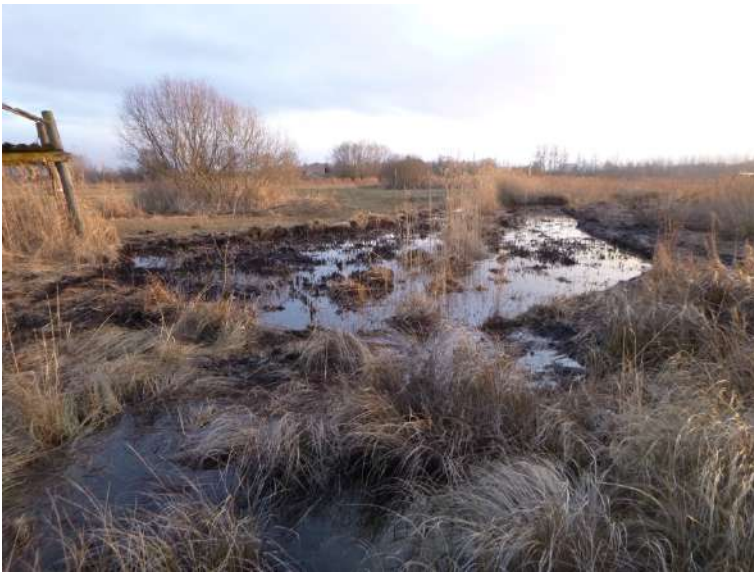
Photo 25 : Etrépage mécanique au centre du Pré Lecomte
