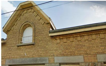
La brique est omniprésente. Elle compose les murs ou bien se limite aux chaînages, linteaux et corniches. Elle peut afficher jusqu'à 5 rangées de briques dont une ou deux canelées sous chéneau.
